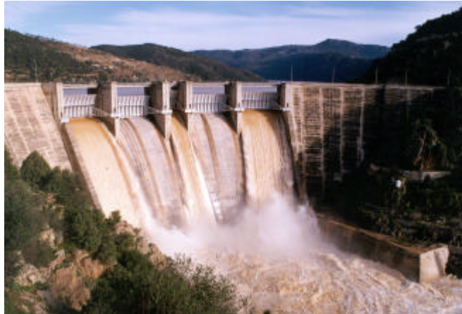
Figura 14. Presa portuguesa de Bemposta durante el paso de avenida.
