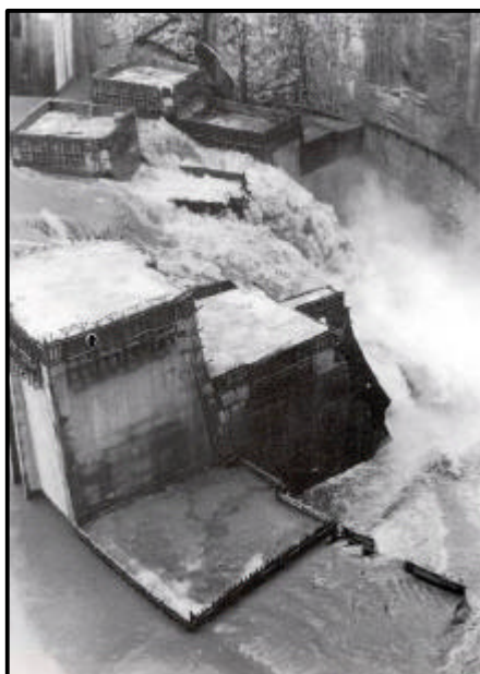
Figura 7. Paso de una avenida de 12.000 m 3 /sg por la presa de Aldeadávila en construcción.
