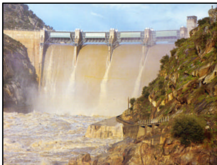
Figura 6. Presa de Saucelle durante una avenida.
