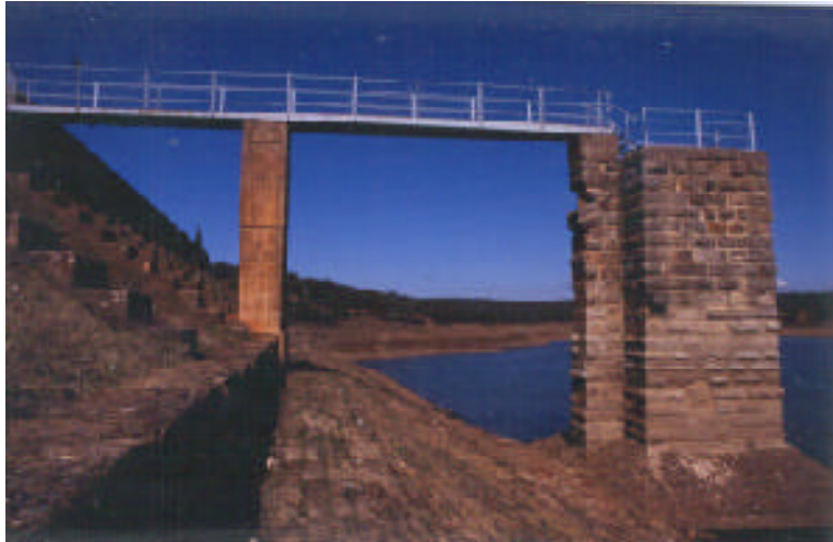
Figura 3. Torre de toma de Cornalvo.
