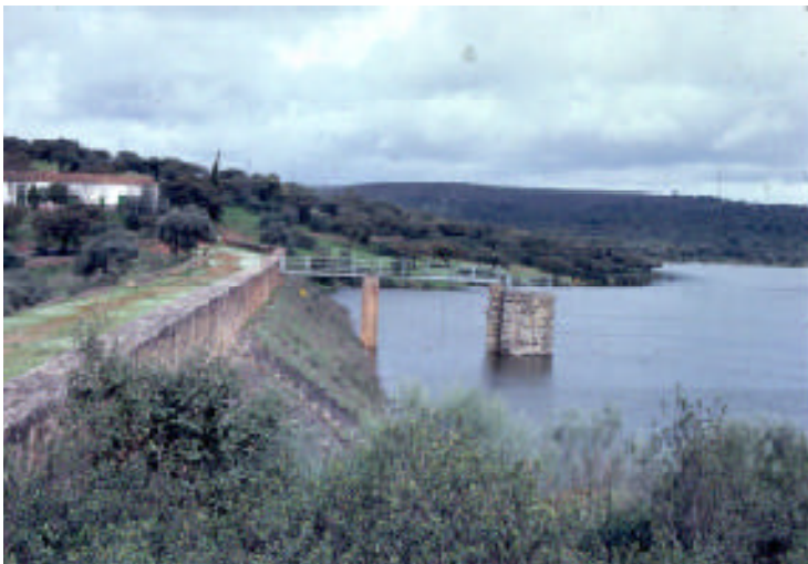
Figura 1. Vista del dique de Cornalvo.
