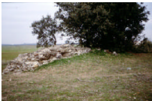
Figura 8. Presa de El Hinojal (Las Tiendas-Montijo).
